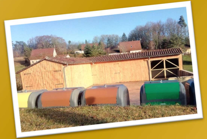
Bardage de l'ancien local à poubelle
